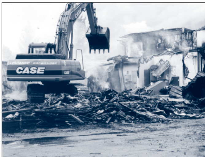
Slika 4: Sanacija požarišča OŠ Podzemelj (vir: PGD Podzemelj)
